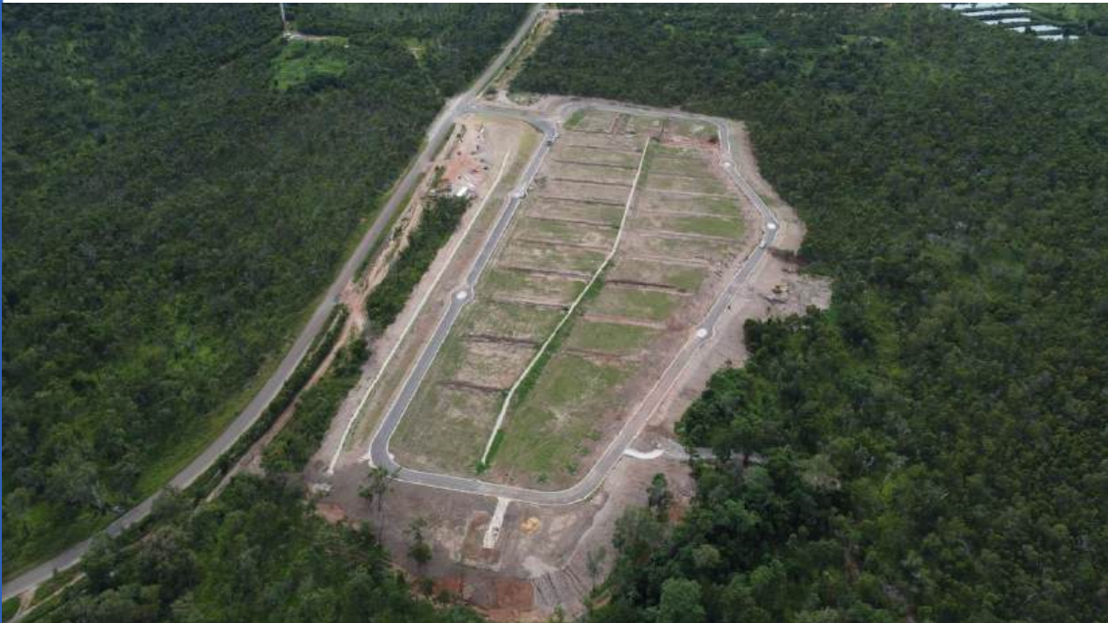
New Sub-division Piiramo St
